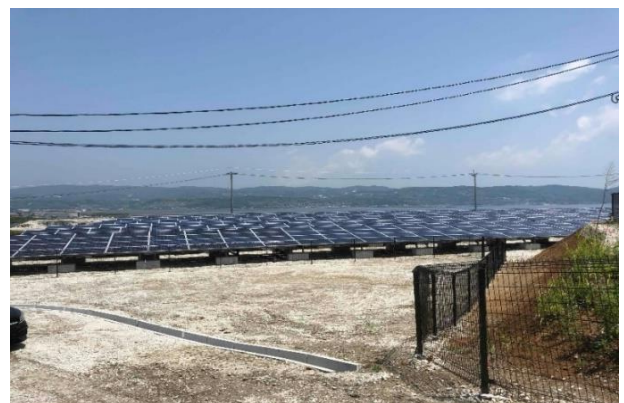
大分県・メガソーラー現場
